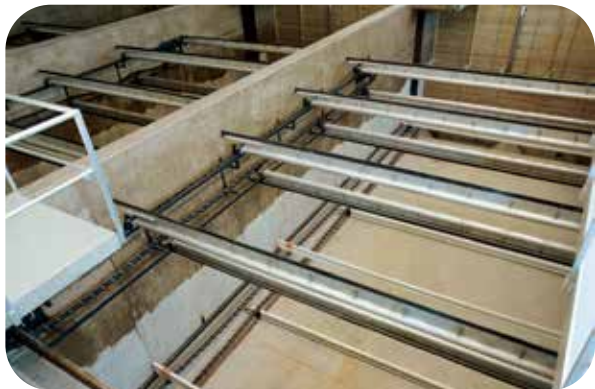
去除表面污泥的链动传动刮泥机
