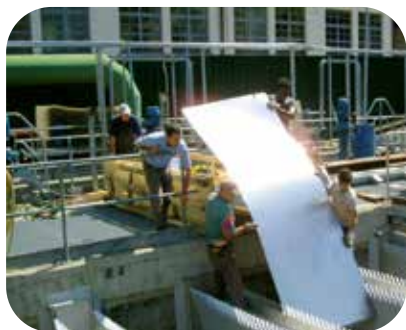
安装人员正在安装斜板 意大利 COMO 污水处理厂
