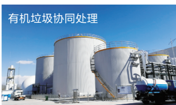
有机垃圾协同处理 通州城市有机垃圾协同厌氧项目 餐厨垃圾200吨/天 污泥100吨/天 市政粪便300吨/天
