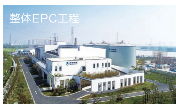
整体EPC工程 苏州工业园区餐厨及绿化垃圾处理一期项目 餐厨垃圾（含过期食品）300吨/天 垃圾压滤液100吨/天
